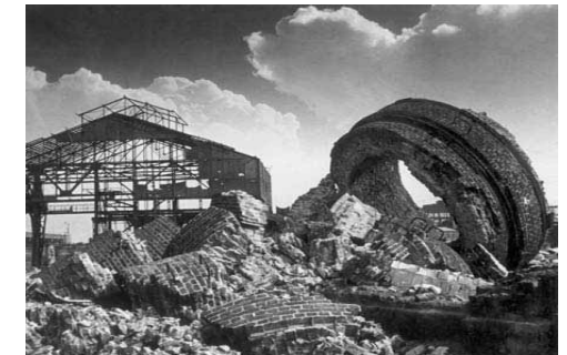
Durch Bombardierung zerstörte Gebäude der Generatorenanlage und durch Demontage gesprengter Schornstein, Nähe der Krupp Hauptverwaltung, 1950
